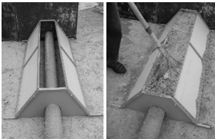
Рис.1 - Процесс формирования профиля обсыпки с помощью кондуктора
